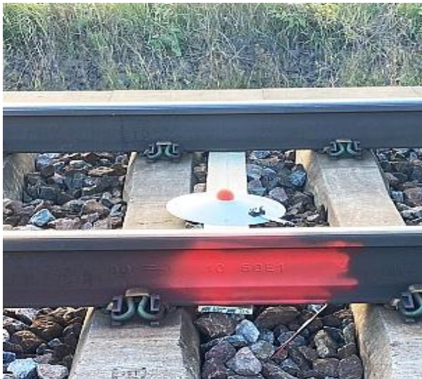
Foto 1: Mikrofonplatta placerad på ballasten mellan rälen
